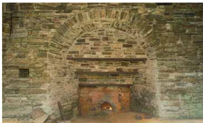
Ansicht des Arbeitsgewölbes am Hochofen
